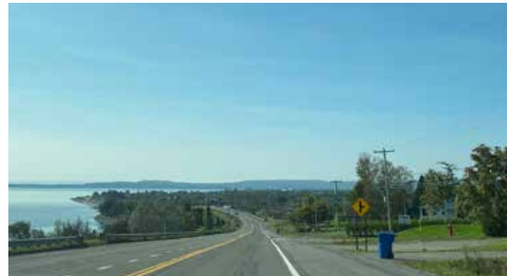
Figure 19 : 04_Surplomb sur le viaduc de la 132, en direction de Saint-Omer.
