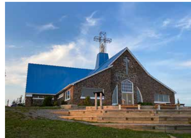
Figure 3 : La chapelle du Parc régional du Mont Saint-Joseph construite en 1935.
