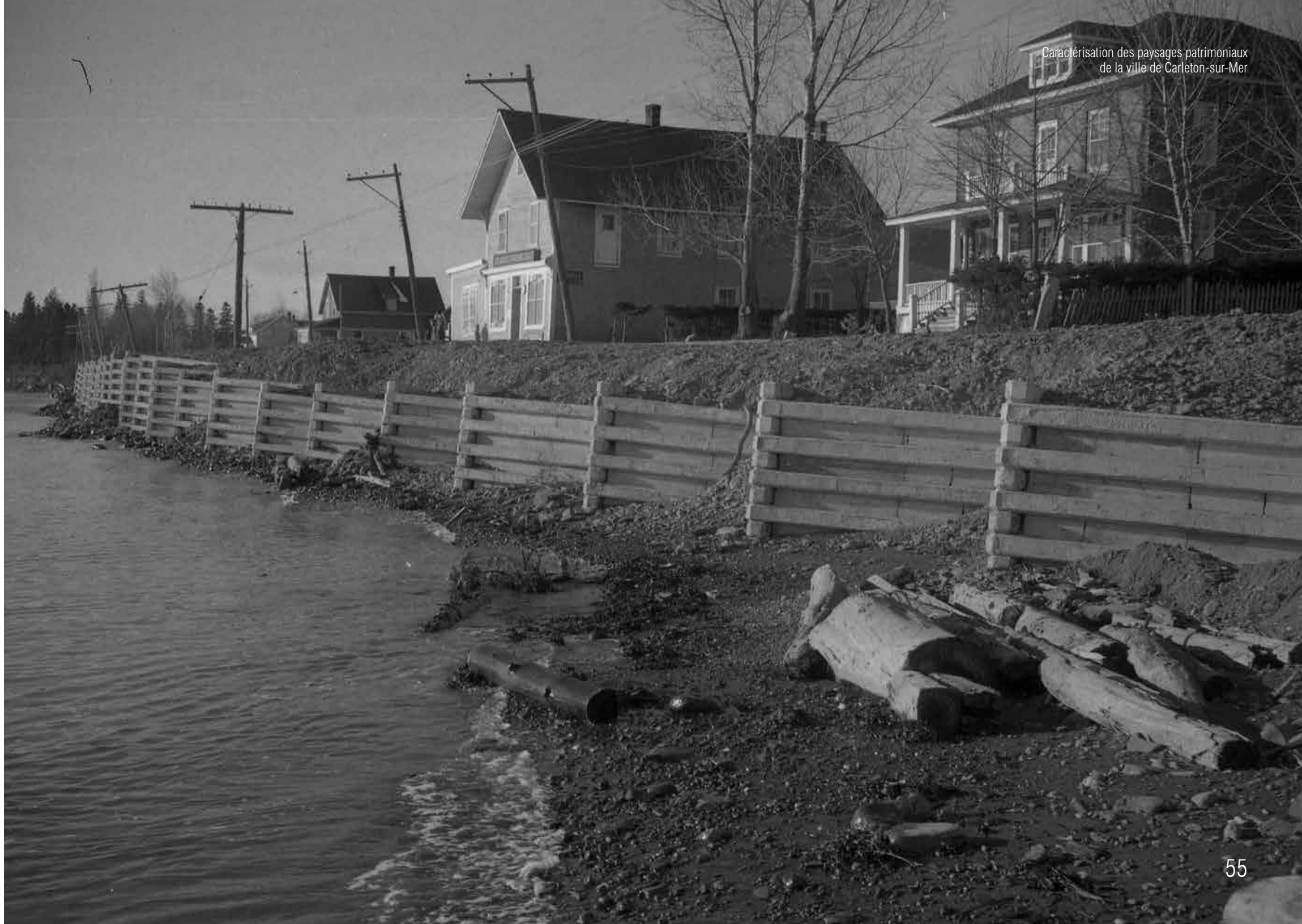
Figure 91 : La photo, prise en 1952, montre la première itération de l'ouvrage du mur de soutènement SOURCE : Maurice Gravel (BAnQ).
