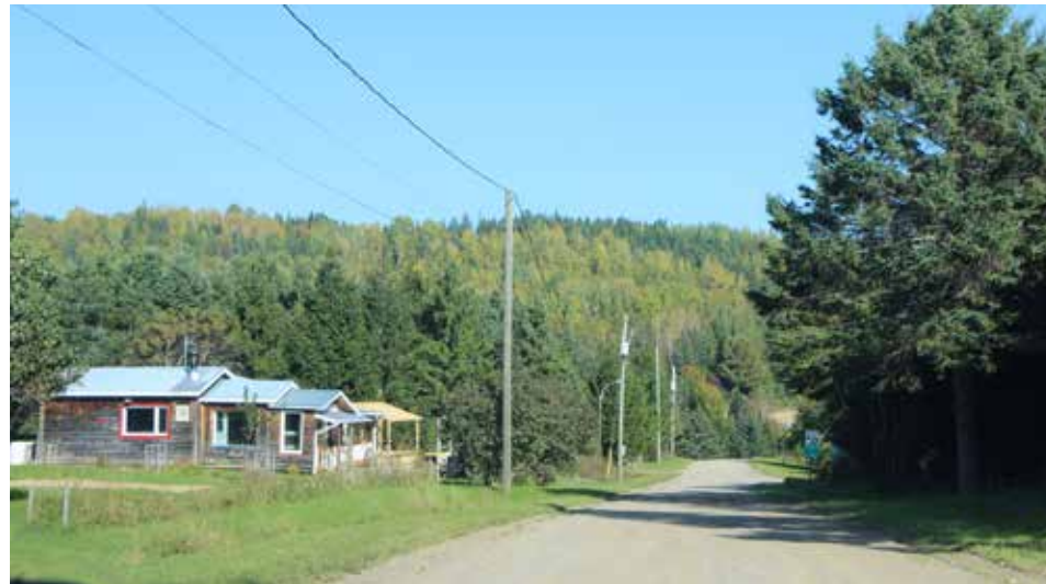
Figure 195 : Deux photographies actuelles des maisons patrimoniales encore présentes. Certaines sont en mauvais état.
