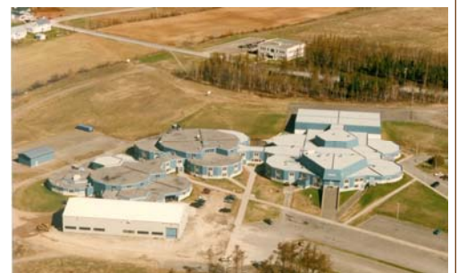
L'architecture de l'école secondaire Antoine-Bernard s'articule autour de trois pavillons. Photo : Collection Écomusée Tracadieche.
